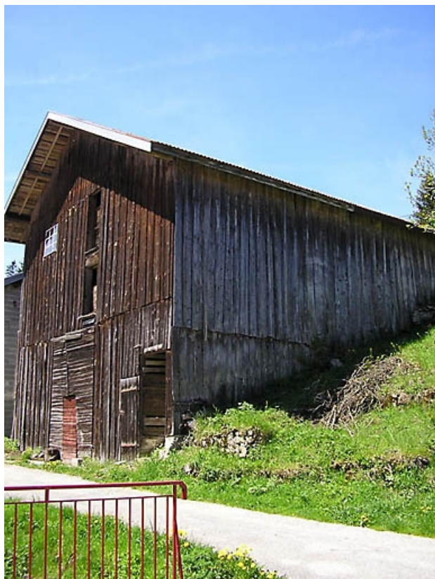
Pignon avec entrée et façade latérale vus de trois quarts.
