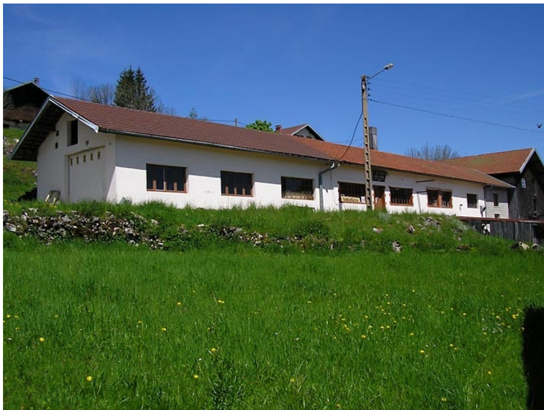
Façade postérieure et pignon nord vus de trois quarts.
