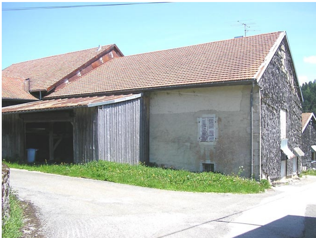
Pignon sud-ouest et façade postérieure avec séchoir à bois vus de trois quarts.
