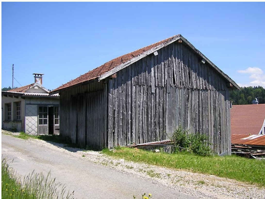
Façade postérieure de la remise (?) vue de trois quarts.
