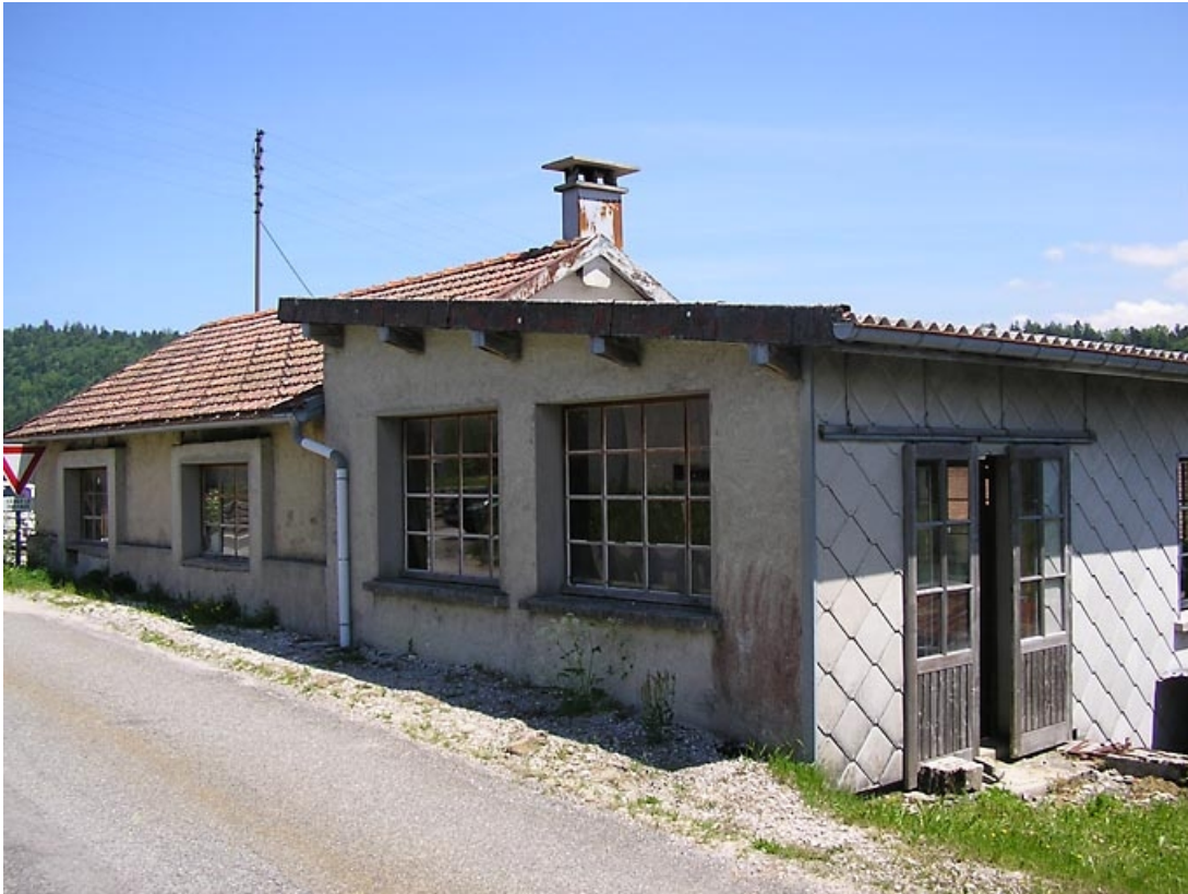
Entrée et façade latérale vues de trois quarts. 39, Prénovel
