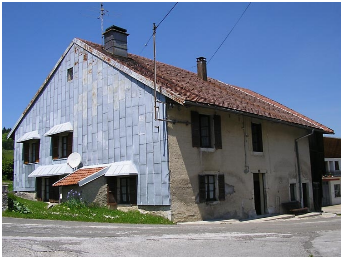
Façade antérieure et pignon sud-ouest vus de trois quarts. 39, Prénovel
