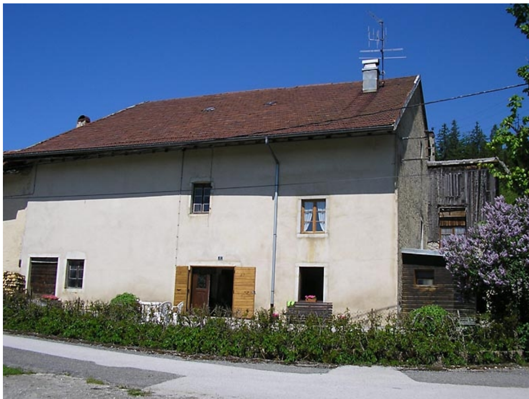
Façade antérieure et remise sur pignon nord-est vues de trois quarts.
