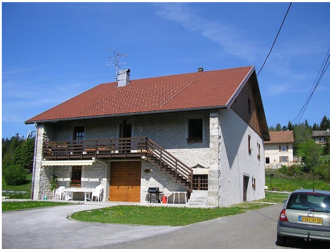
Façade postérieure et pignon sud-ouest.
