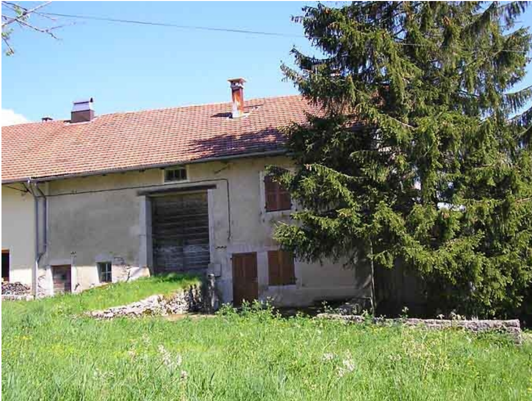
Vue latérale de la façade postérieure et de la levée de grange.
