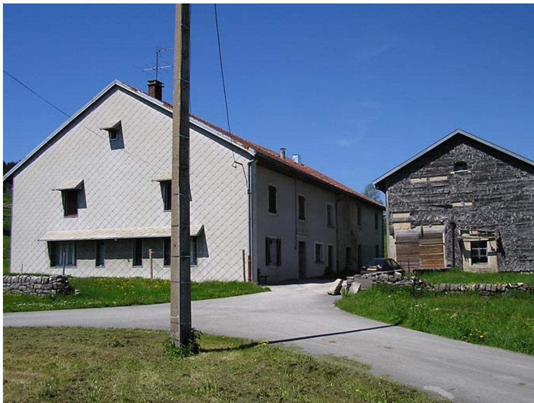
Pignon sud-ouest vu de trois quarts.
