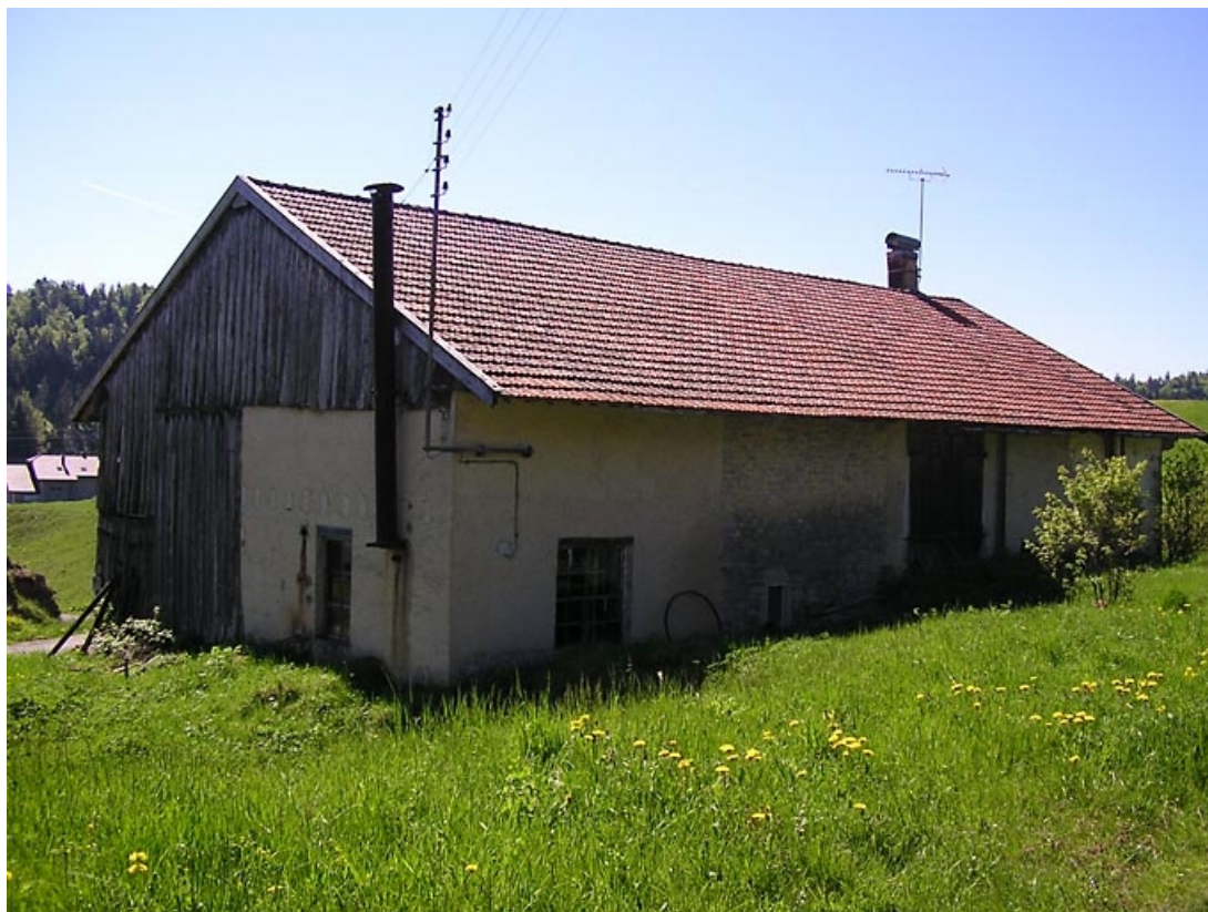
Façade postérieure et pignon nord-est vus de trois quarts.
