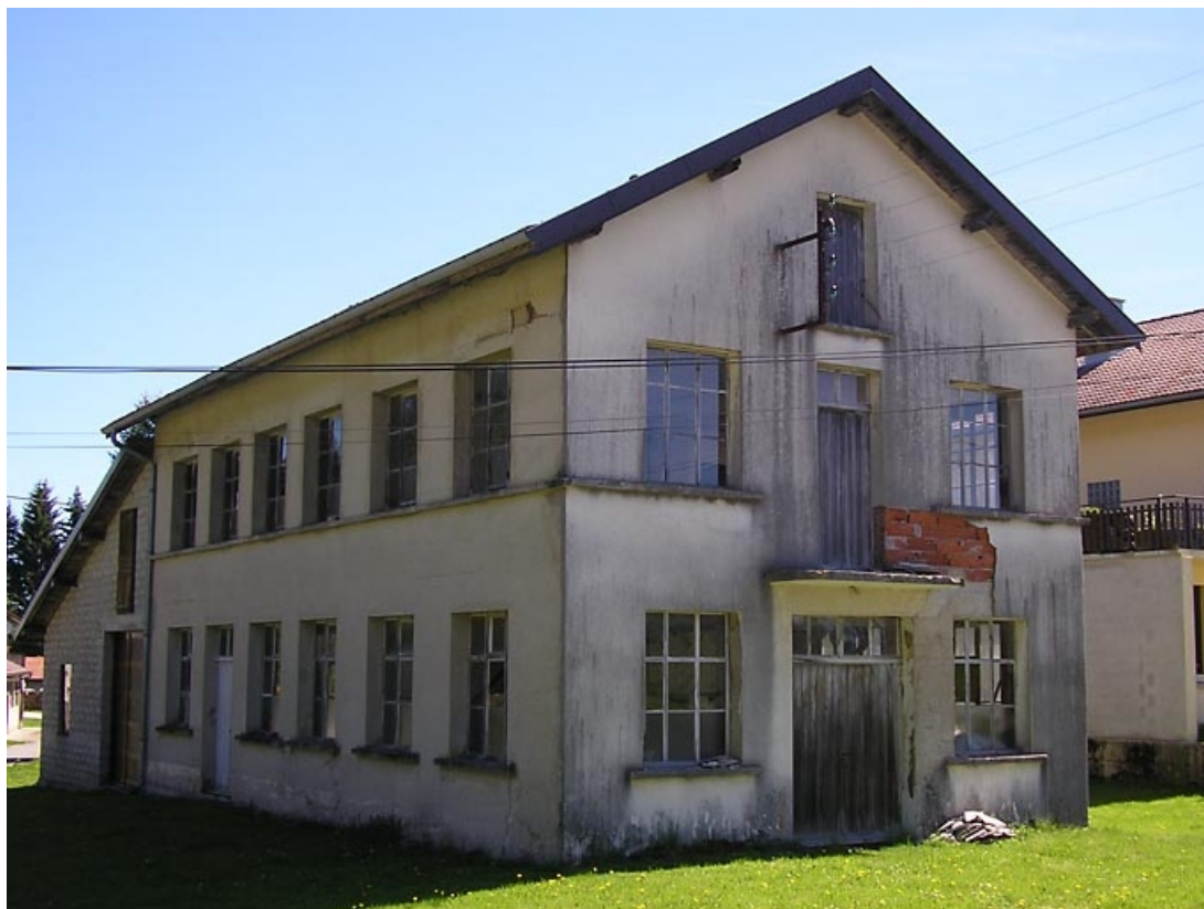
Pignon sud-ouest et façade postérieure vus de trois quarts.
