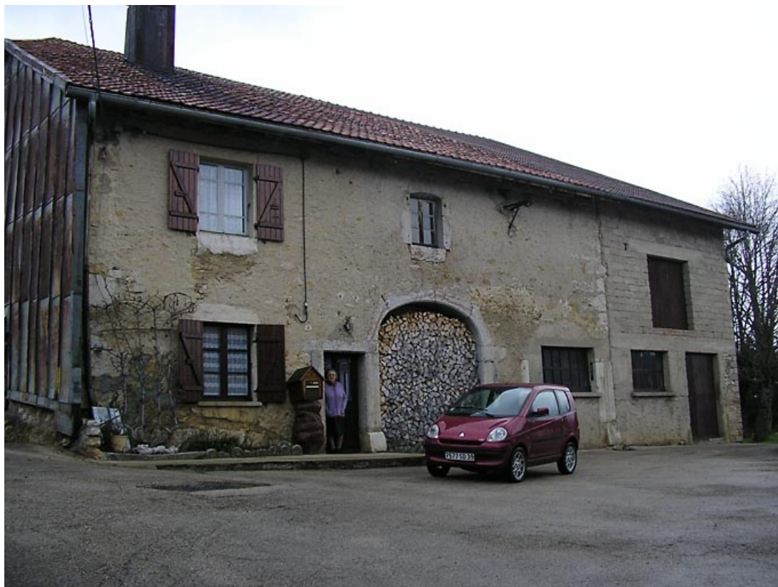
Façade antérieure et partie du pignon sud-ouest vues de trois quarts.
