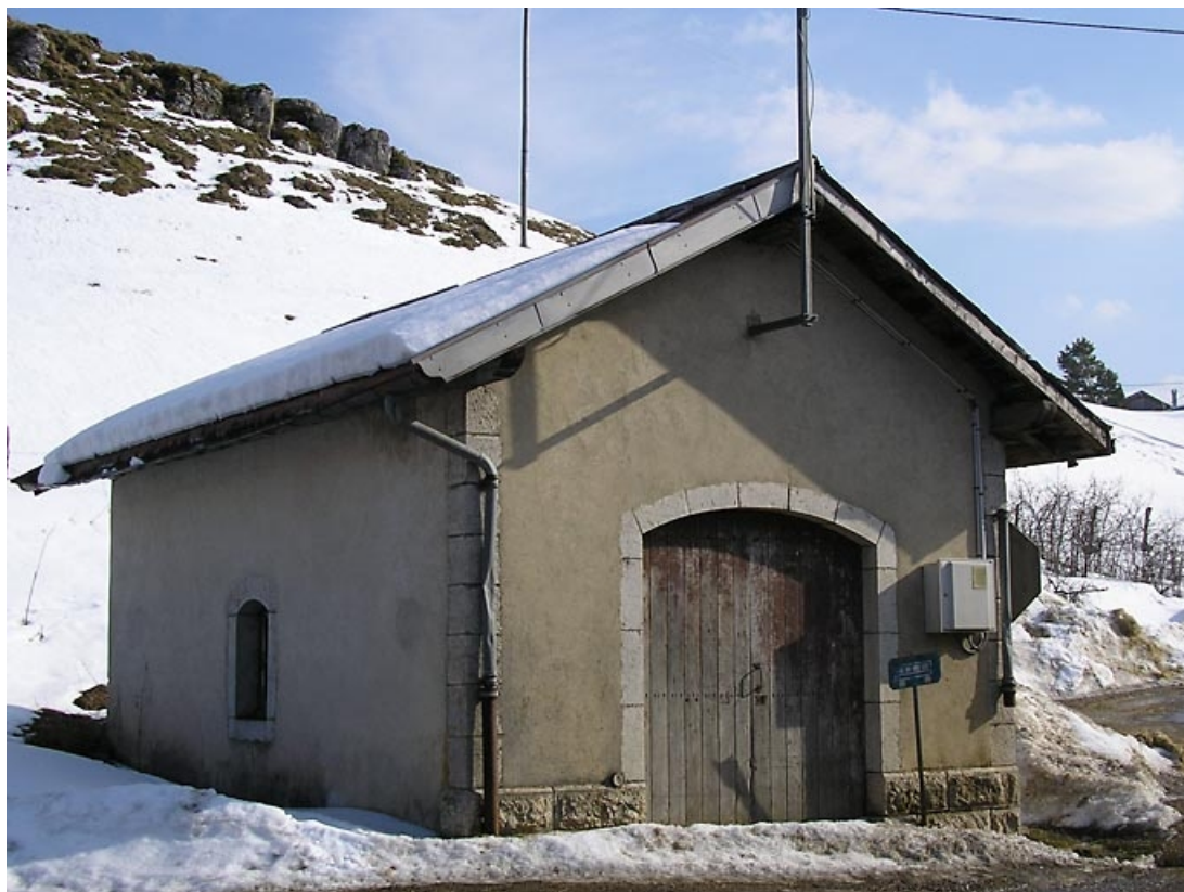
Entrée et façade latérale vues de trois quarts.
