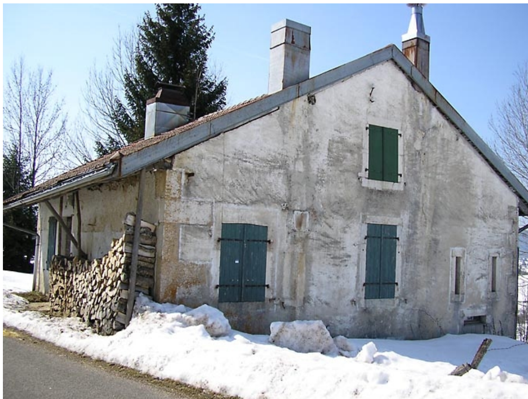
Pignon nord-est et façade latérale vus de trois quarts.
