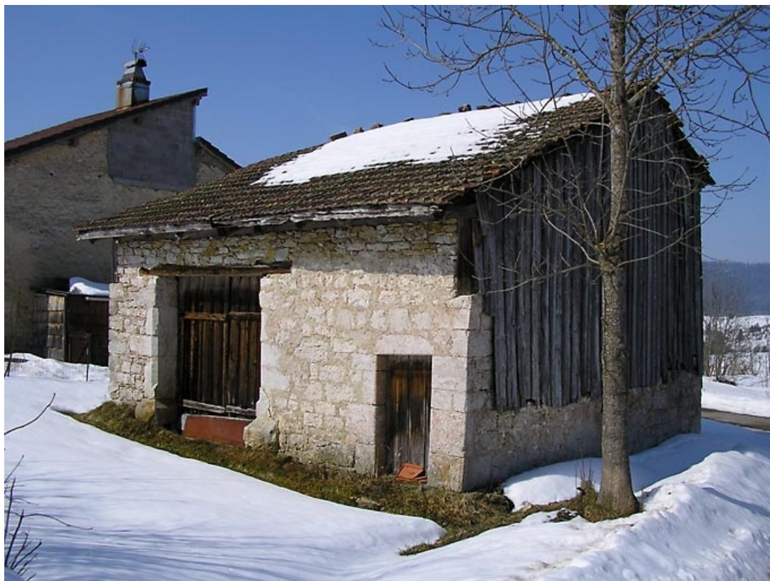
Entrée et pignon essenté vus de trois quarts. 39, Grande-Rivière V.C. 5, lieudit : les Mussillons
