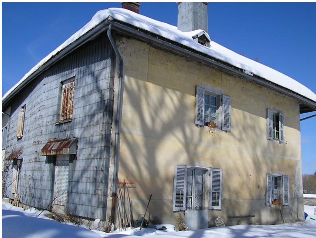
Façade latérale et pignon sud-ouest vus de trois quarts.
