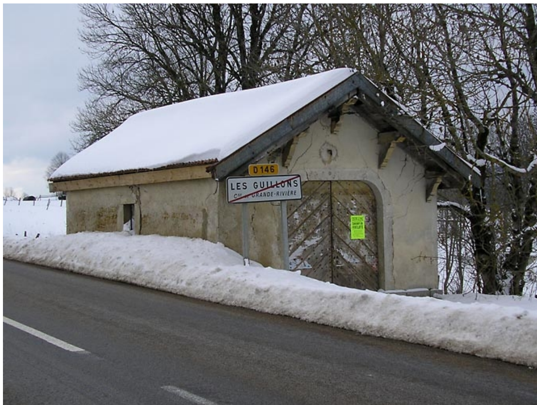
Entrée et façade latérale vues de trois quarts. 39, Grande-Rivière C.D. 146, lieudit : les Guillons
