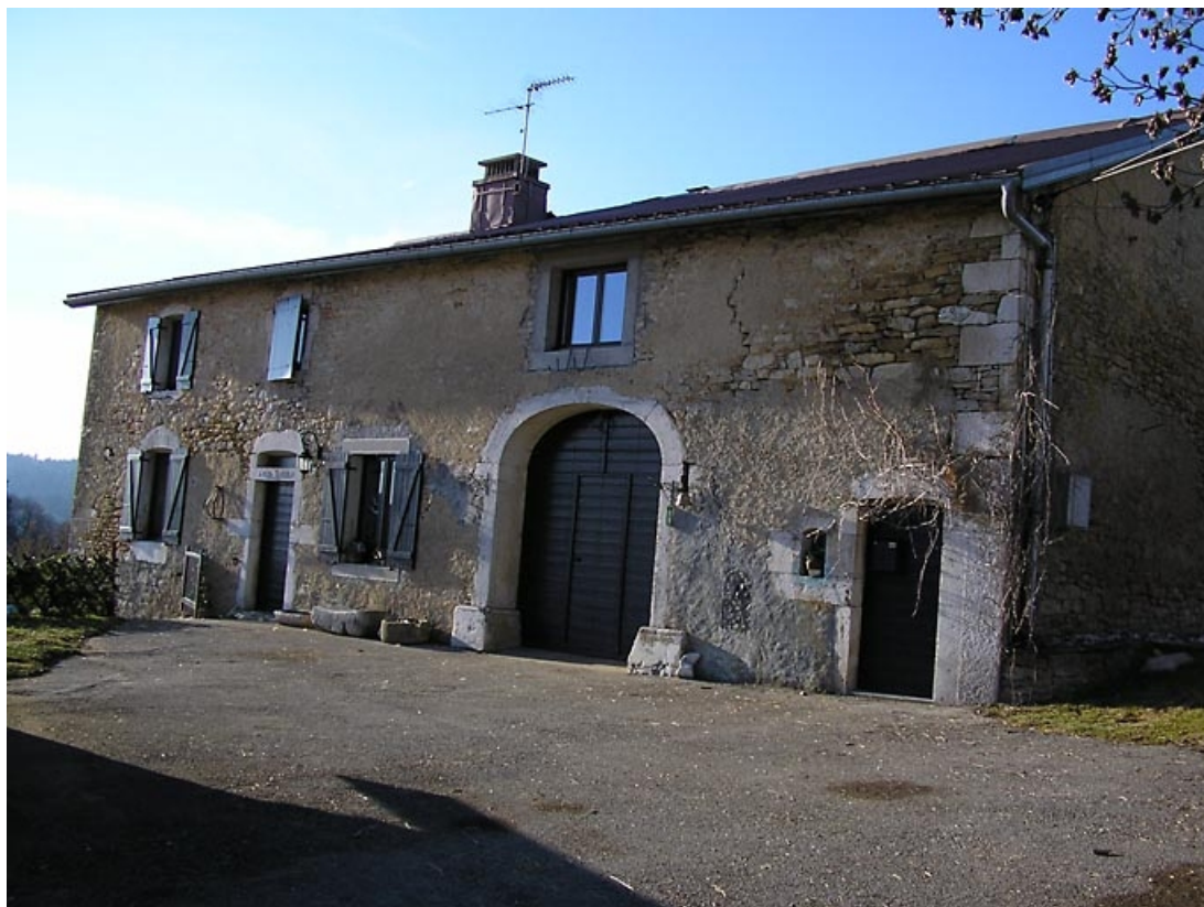
Façade antérieure vue de trois quarts.
