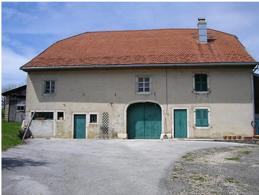
Vue générale de la façade antérieure et de la remise.
