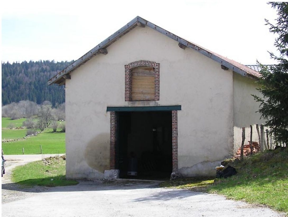
Vue de l'entrée du hangar agricole.
