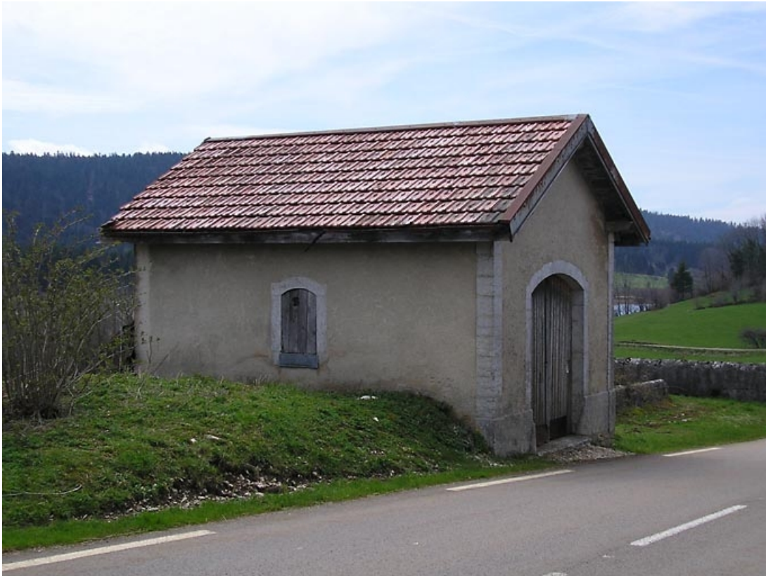
vue de trois quarts sur façades latérale et antérieure.
