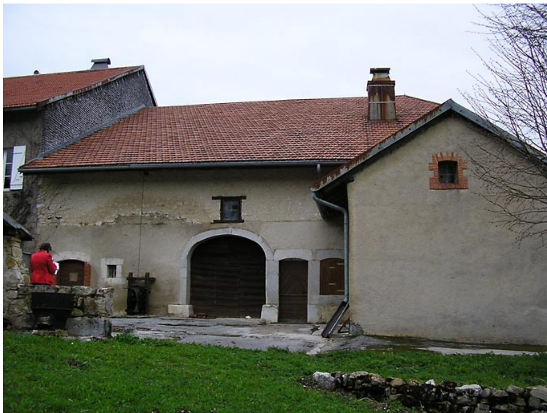
Vue générale de la façade postérieure et de l'atelier.
