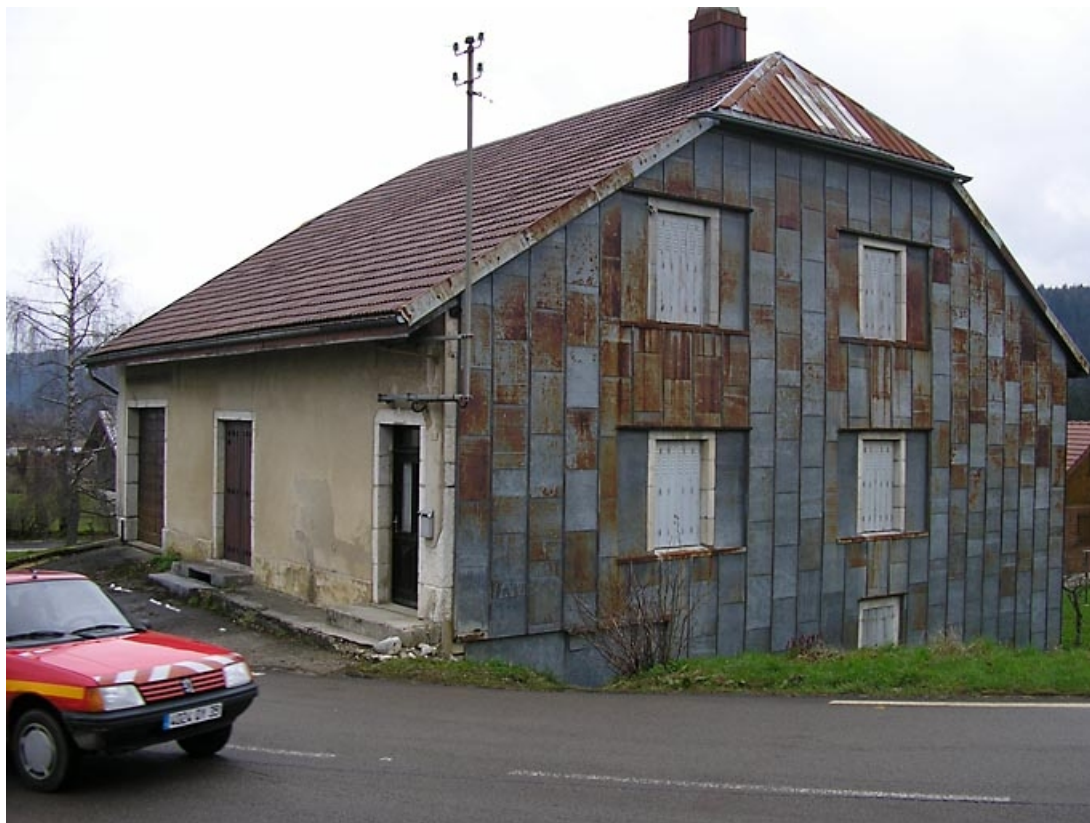
Pignon sud-ouest et façade postérieure vus de trois quarts. 39, Lac-des-Rouges-Truites C.D. 437 155, lieudit : les Thévenins
