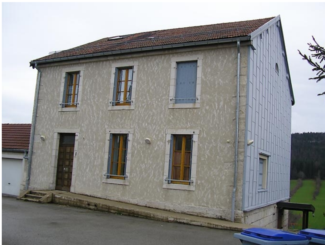
Façade antérieure et pignon sud-ouest vus de trois quarts.
