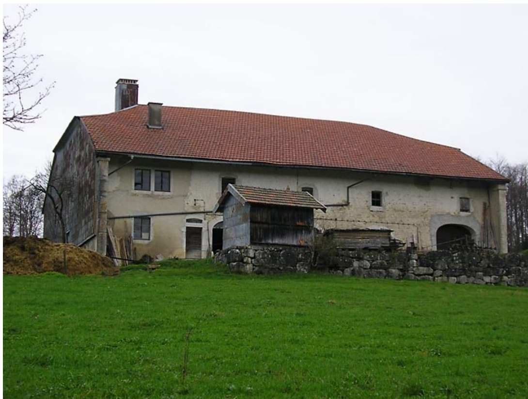
Vue générale de la façade postérieure et de la remise.
