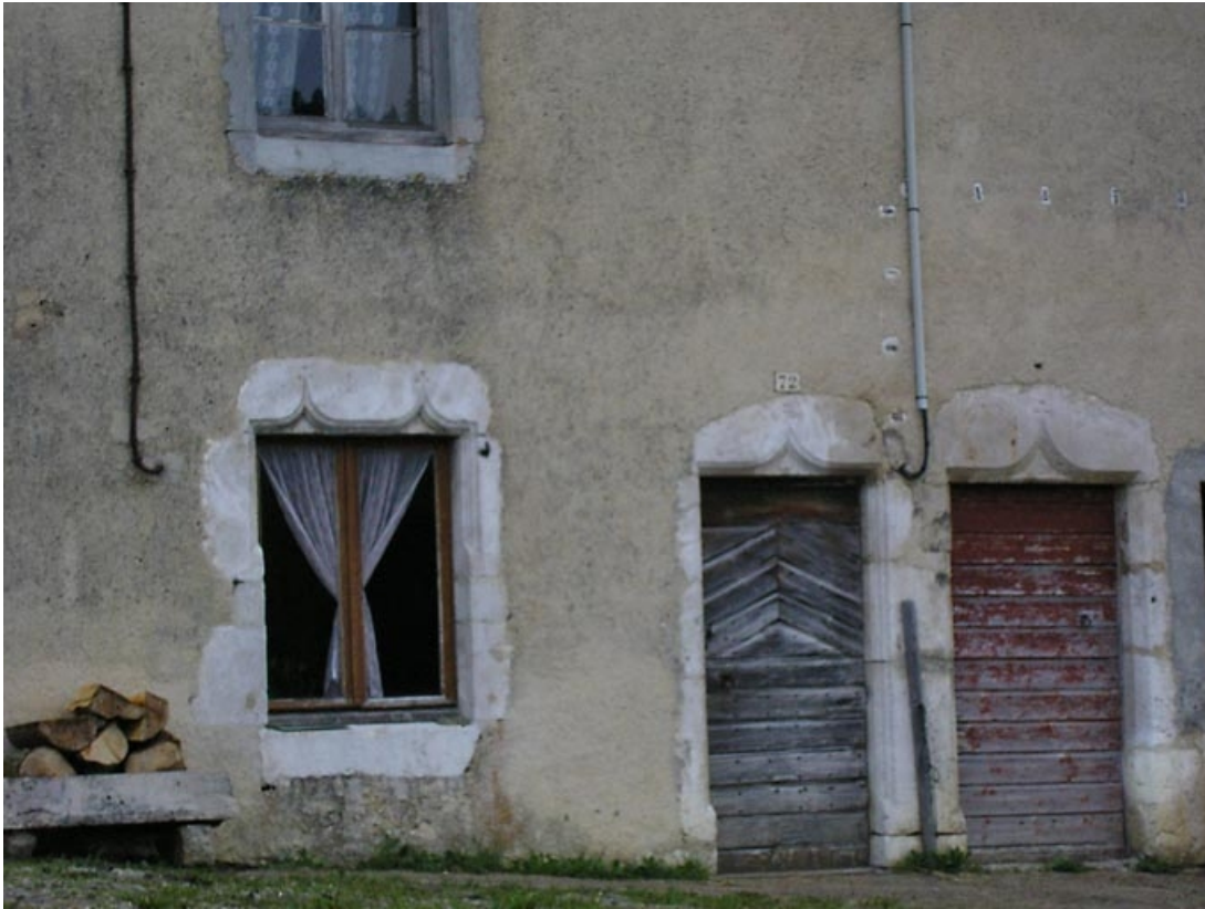
Vue des portes et de la fenêtre avec linteaux en accolade.
