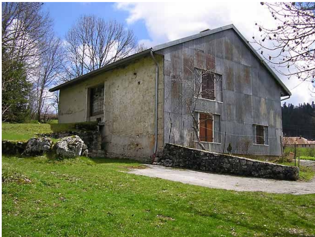
Pignon sud-ouest et façade latérale vus de trois quarts.
