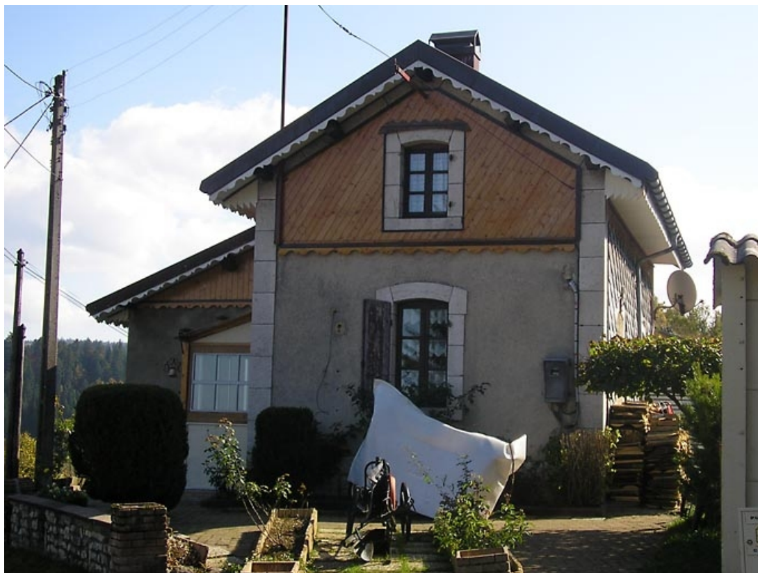
Vue latérale de la façade ouest.
