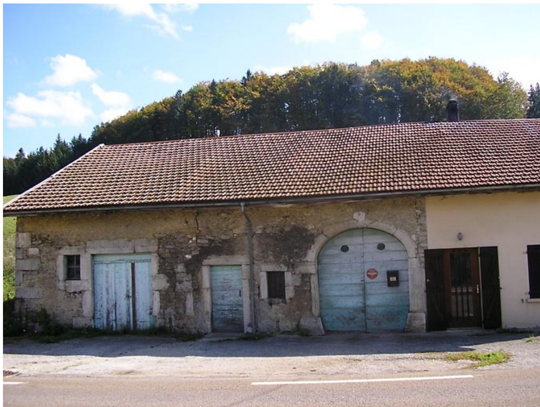
Vue générale de la façade antérieure.
