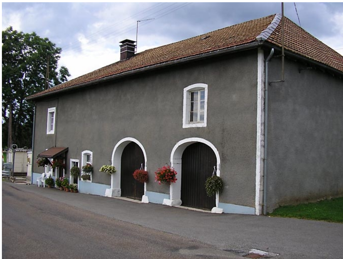
Façade antérieure et pignon nord-est vues de trois quarts.
