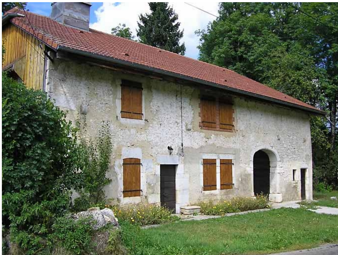
Vue de la façade antérieure.
