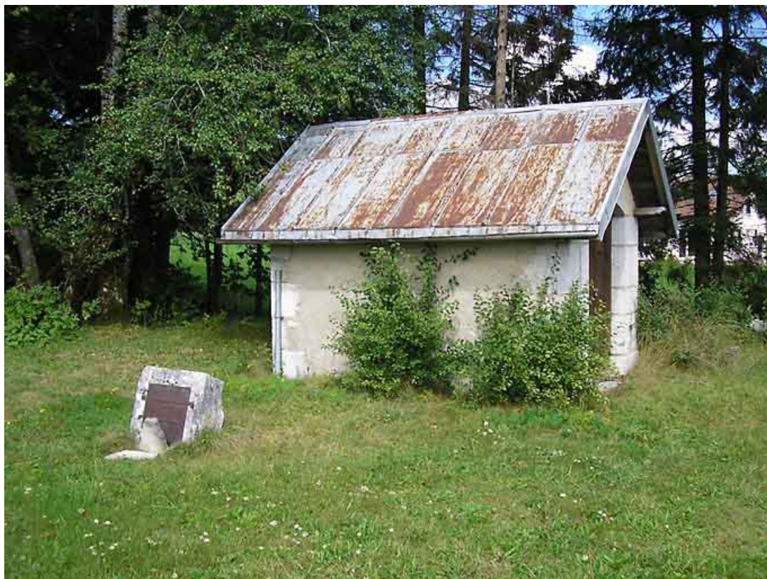
Façade latérale de la resserre et citerne vues de trois quarts.
