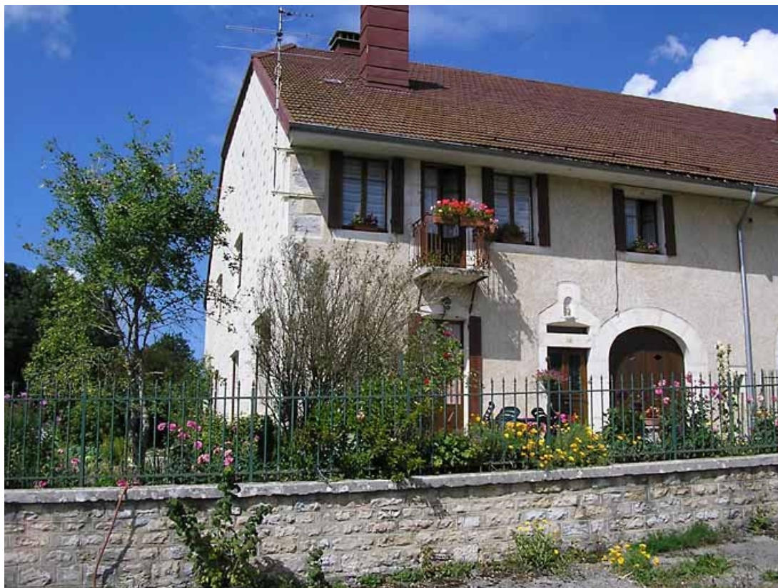
Vue latérale de la façade antérieure et d'une partie du pignon sud-ouest.
