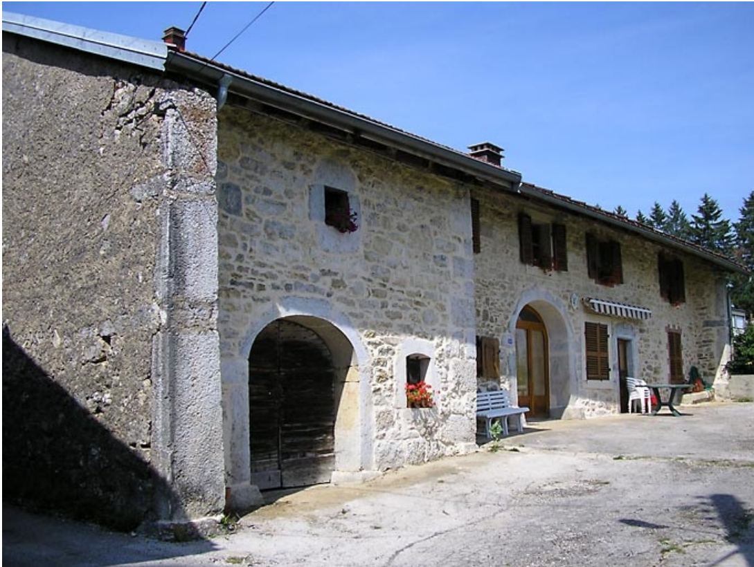
Façade antérieure et pignon nord-est vus de trois quarts. 39, Saint-Pierre
