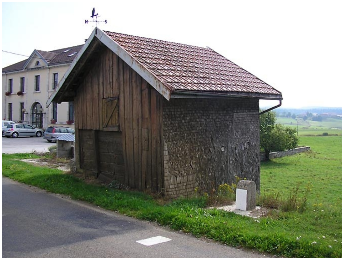
Entrée et façade sud-ouest vues de trois quarts.
