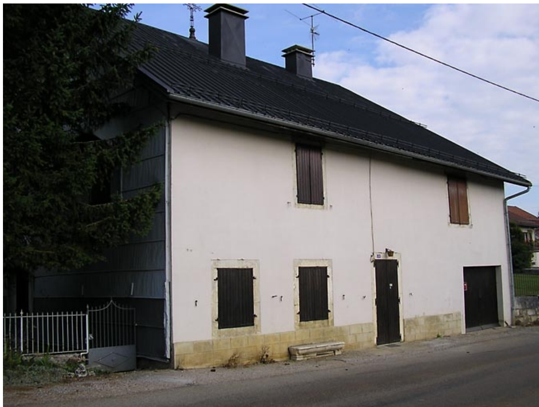
Vue de la façade antérieure et du pignon sud-ouest.
