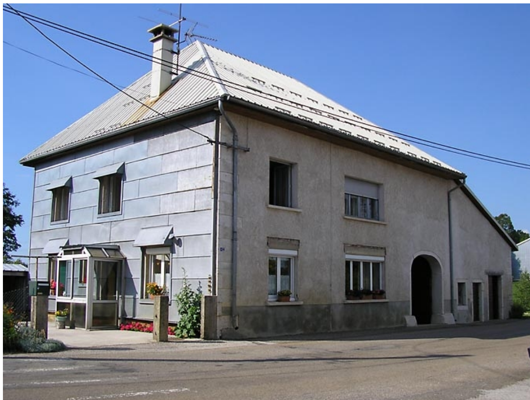
Façade antérieure, remise et pignon sud-ouest vus de trois quarts.
