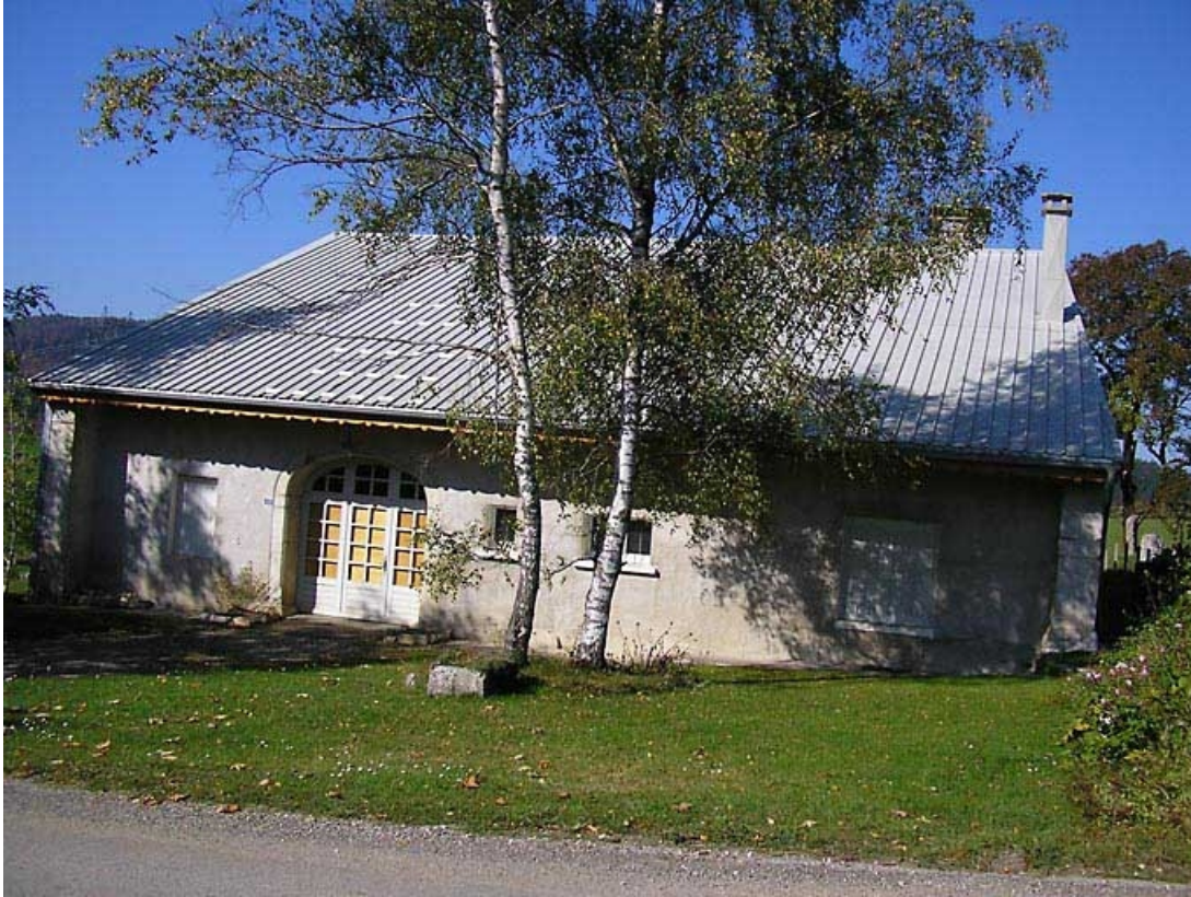
Vue latérale de la façade postérieure.
