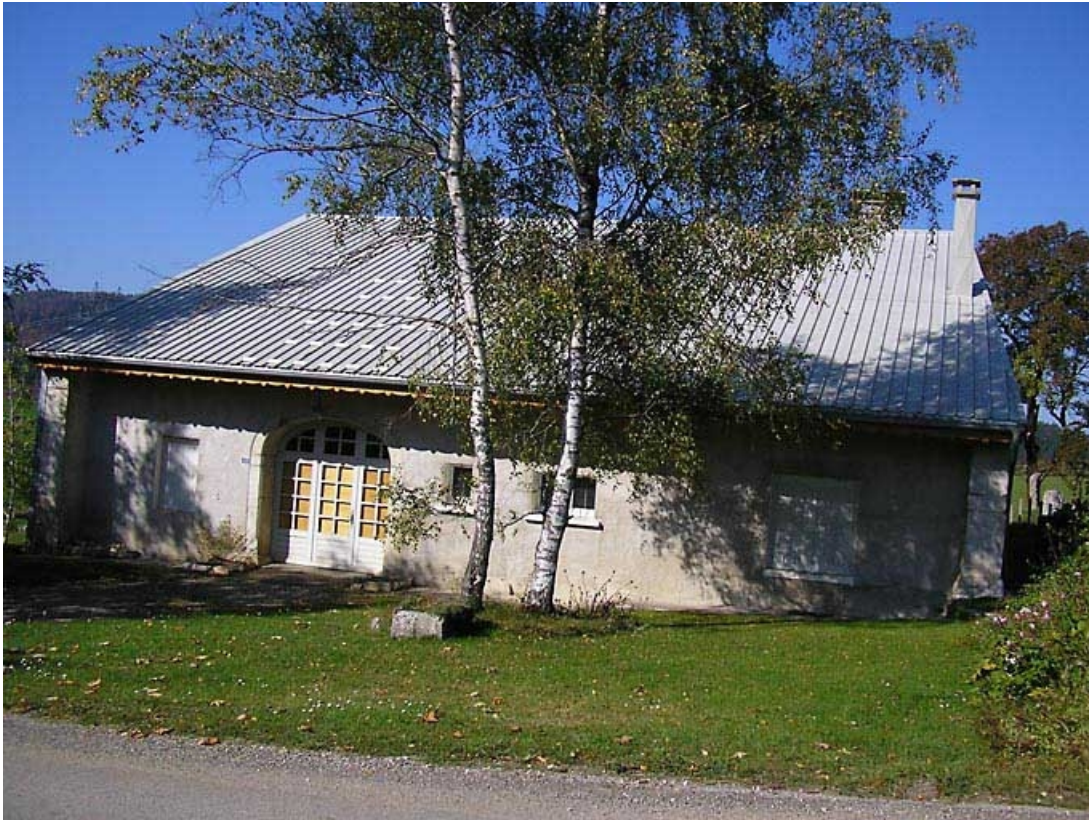
Vue latérale de la façade postérieure.
