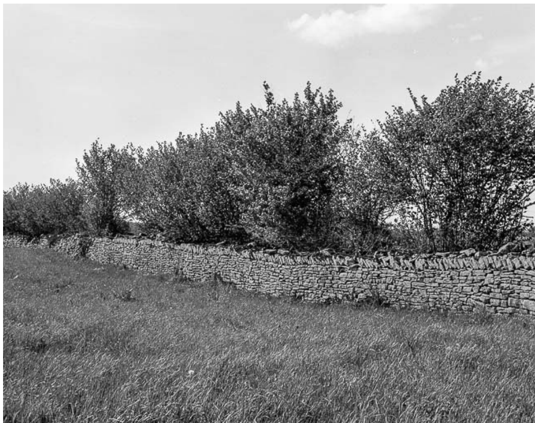
Mur en pierre sèche au lieudit Chaumois-Boivin.
