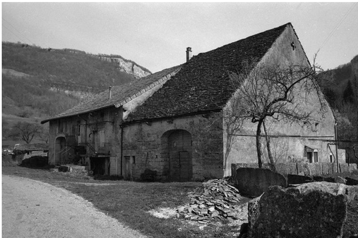
Façades antérieure et latérale droite en 1974.
