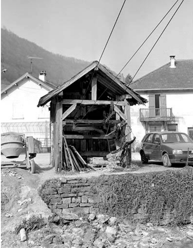
Vue d'ensemble du transporteur automatique par câble. Le local abrite un treuil permettant d'acheminer le lait, collecté sur le plateau, à la fromagerie du village.
