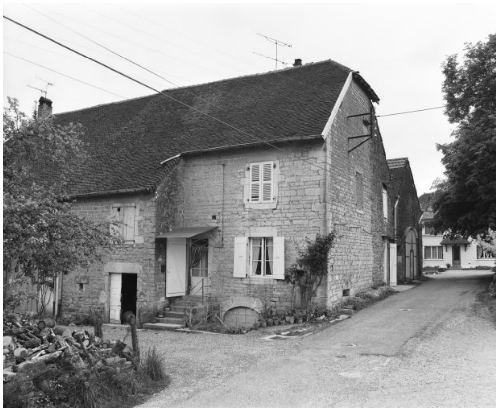
Façade antérieure et latérale droite.
