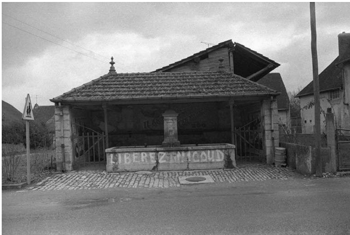
Fontaine-lavoir, pierre, XIXe siècle : vue depuis la route.
