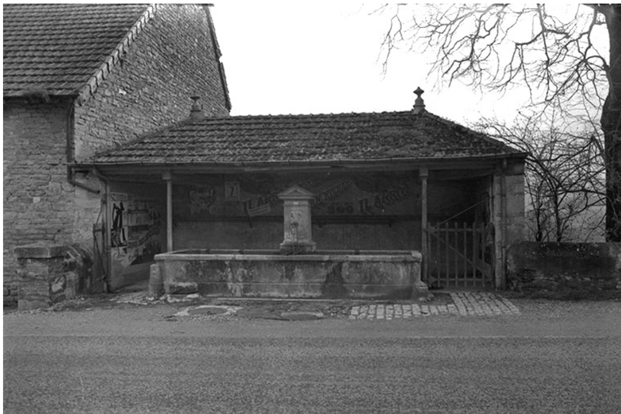
Fontaine-lavoir, pierre, XIXe siècle : vue depuis la route. 39, Plainoiseau
