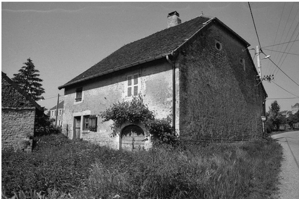
Ferme cadastrée 1951 A3 242 située le long du chemin vicinal ordinaire du Pin à Montain : façade antérieure. 39, Le Pin
