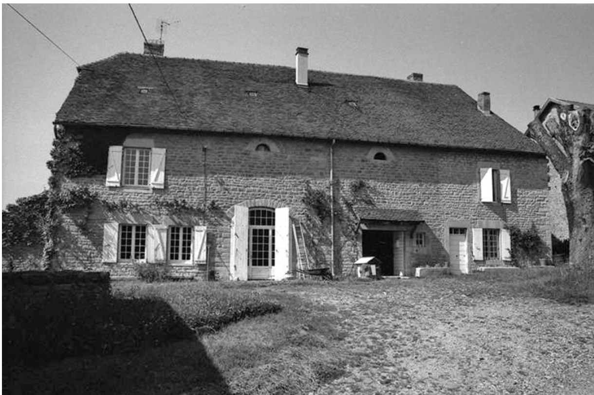
Ferme cadastrée 1951 B1 située le long du chemin départemental n° 208 du Pin à Lons-le-Saunier : façade antérieure. 39, Le Pin
