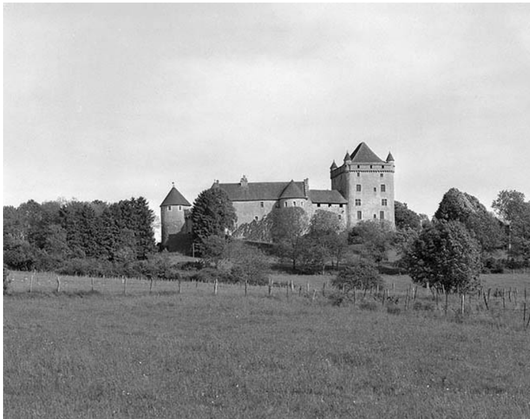
Façade ouest : vue éloignée.
