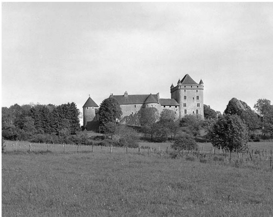
Façade ouest : vue éloignée.
