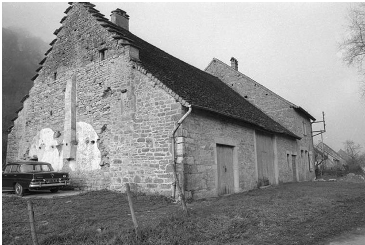
Ferme cadastrée 1965 AD 376 : façades antérieure et latérale gauche. A noter le toit à "pas de moineaux". 39, Nevy-sur-Seille
