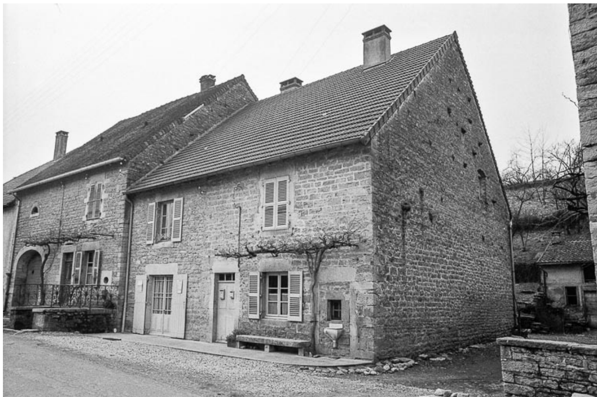
Maison cadastrée 1965 AD 254, située le long du chemin départemental n° 70 : façades antérieure et latérale droite. 39, Nevy-sur-Seille
