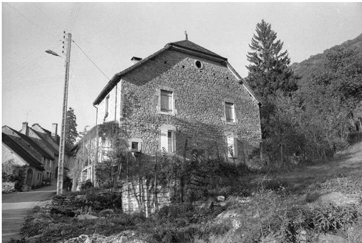
Maison cadastrée 1965 AD 105 : façade est. 39, Nevy-sur-Seille
