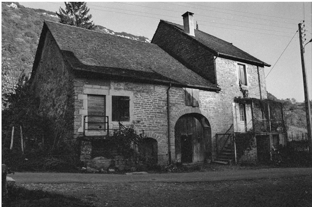
Maison cadastrée 1965 AD 105 : façade sud.
