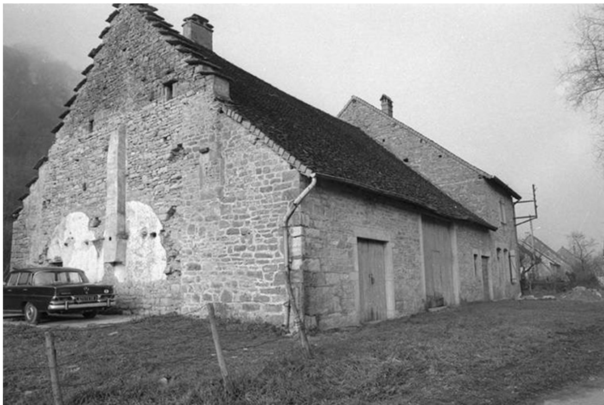
Ferme cadastrée 1965 AD 376 : façades antérieure et latérale gauche. A noter le toit à "pas de moineaux". 39, Nevy-sur-Seille
