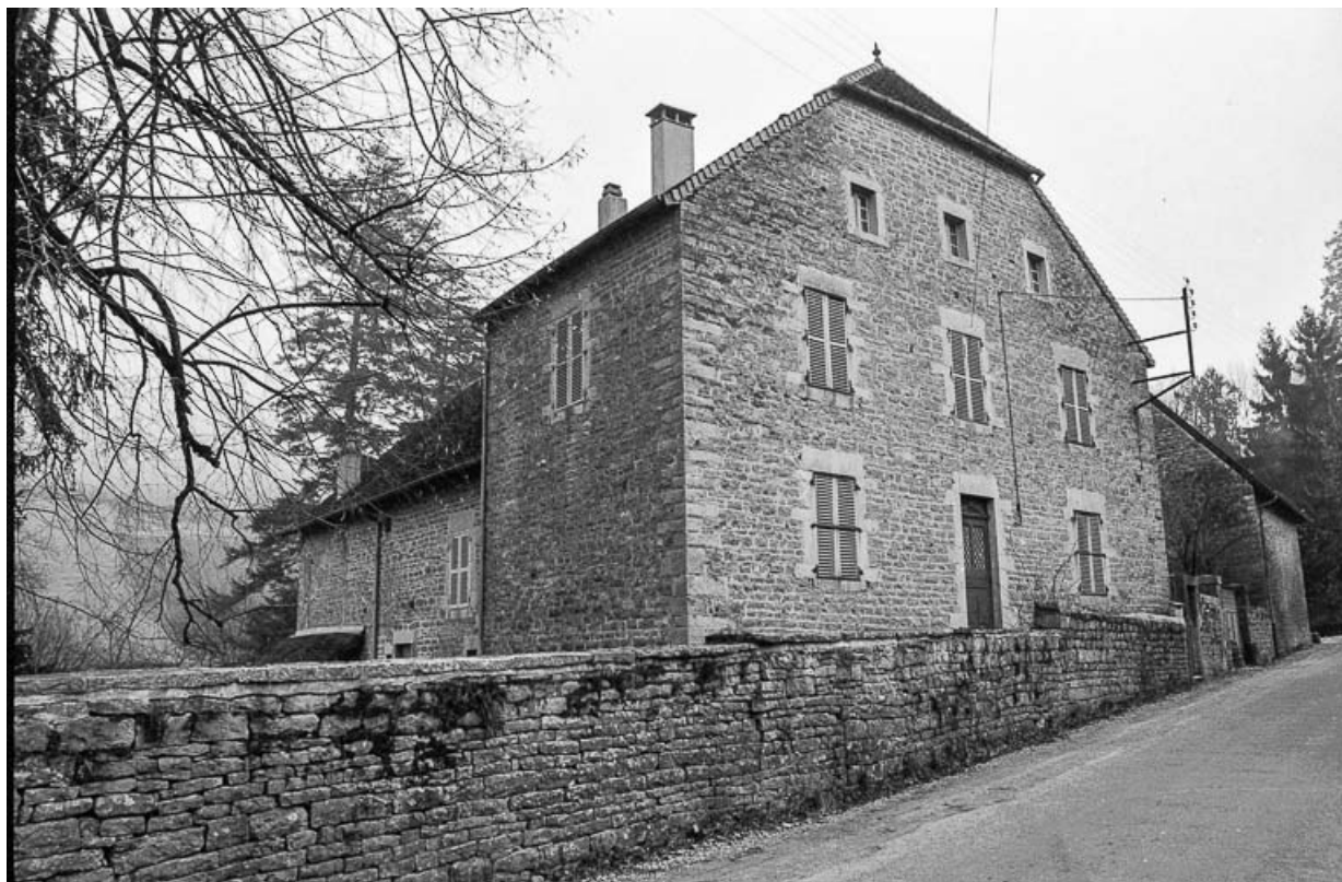
Maison cadastrée 1965 AD 194, située le long du chemin départemental n° 70 : façade sur rue. 39, Nevy-sur-Seille
