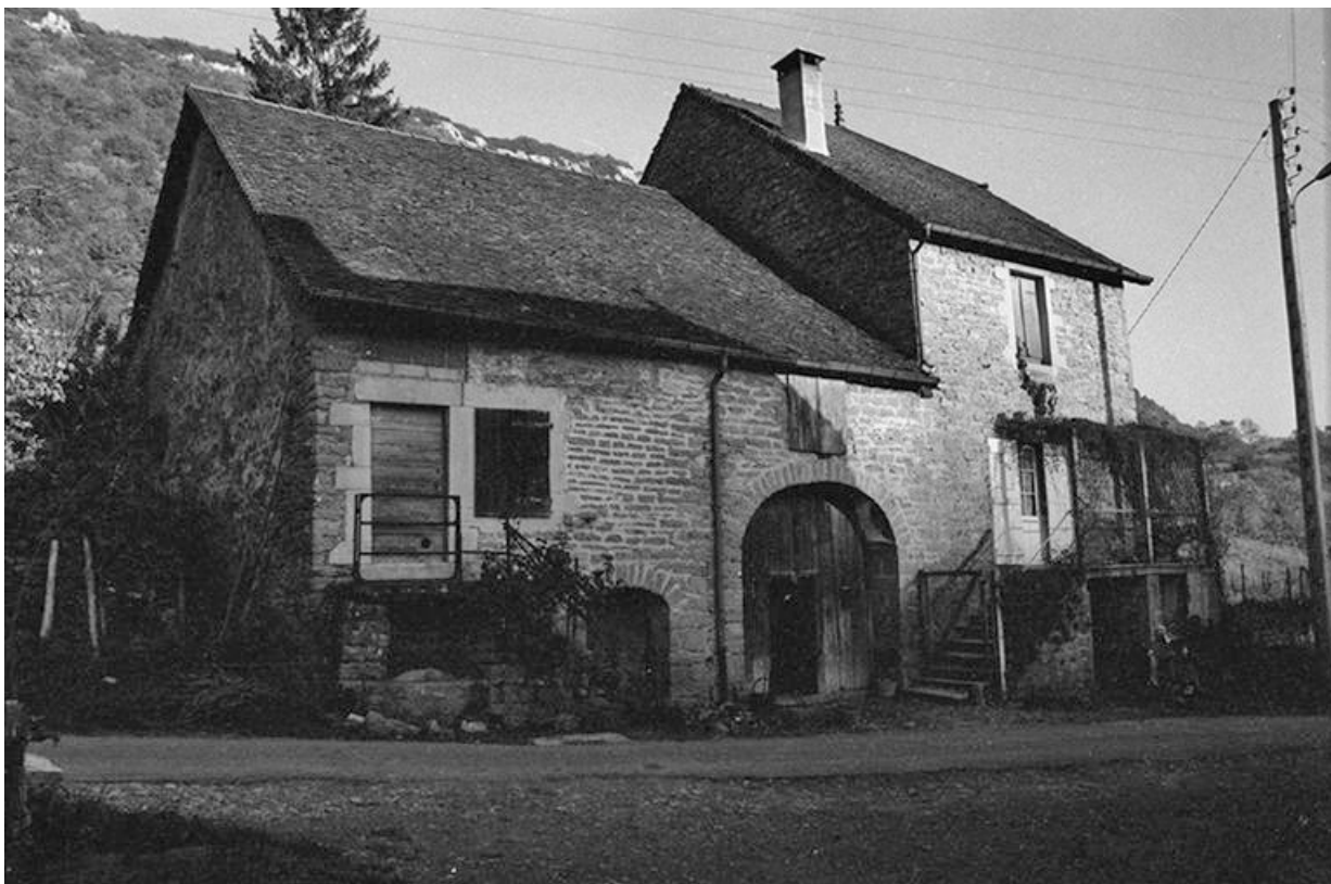
Maison cadastrée 1965 AD 105 : façade sud.
