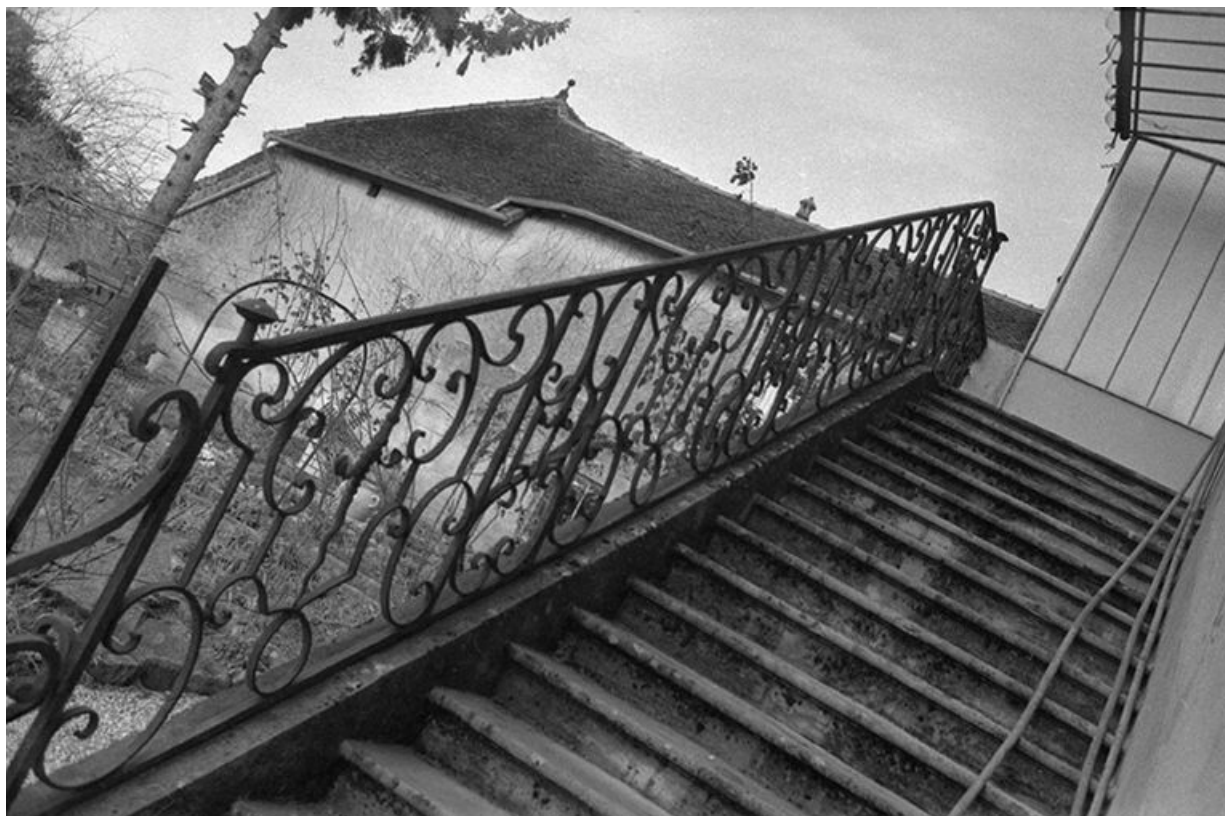
Maison du XVIIe siècle : vue de l'escalier et de sa balustrade en fer forgé 39, Menétru-le-Vignoble
