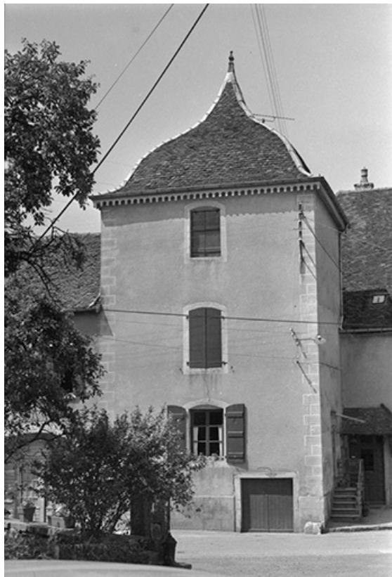
Maison du XVIIe siècle : vue de la tour 39, Menétru-le-Vignoble
