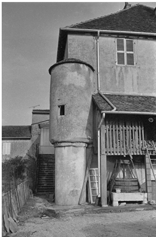
Maison du XVIIe siècle : vue de la tourelle d'angle 39, Menétru-le-Vignoble
