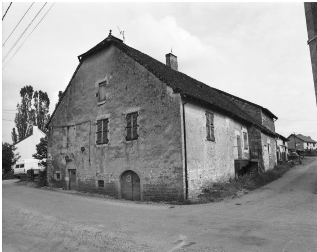
Façades postérieure et latérale droite.
