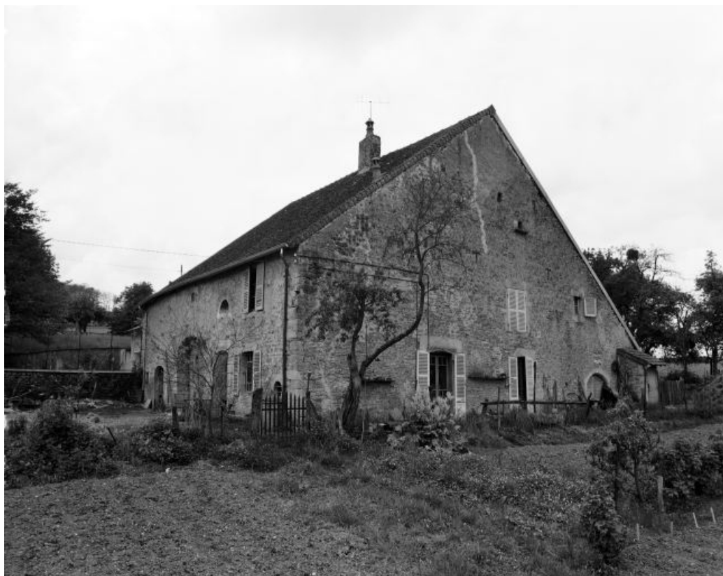
Façades antérieure et latérale droite.
