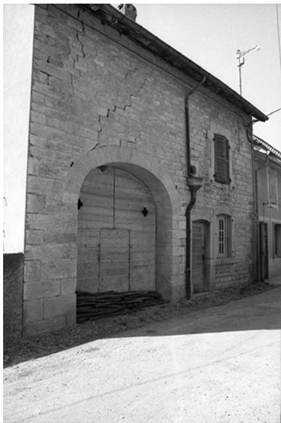
Ferme cadastrée 1967 AH 87, située le long du chemin départemental n° 209 E : façade antérieure vue de trois-quarts gauche. 39, Lavigny
