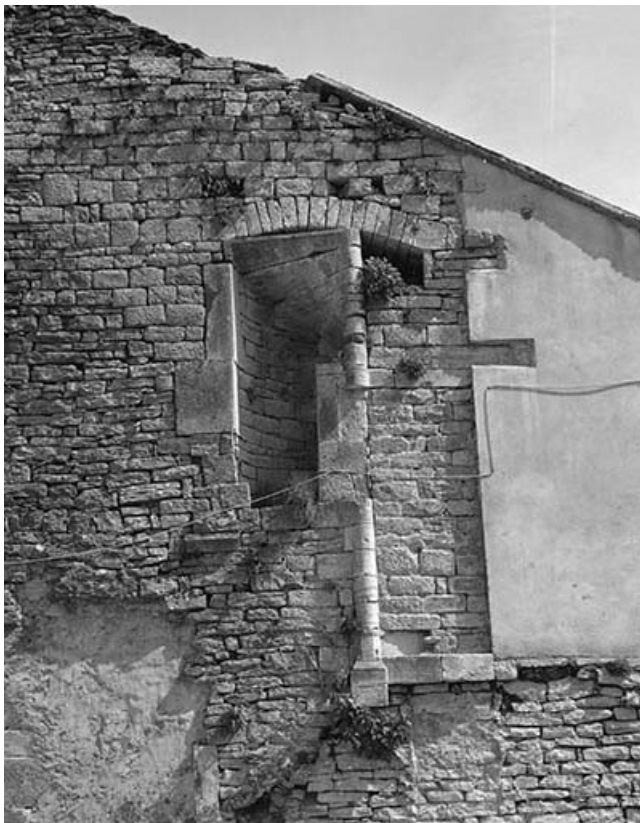
Vestige d'escalier : vue de face.
