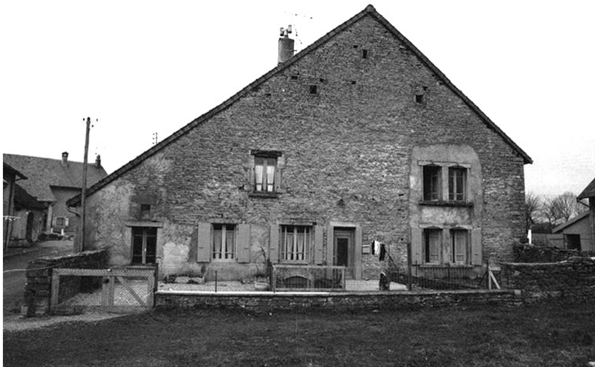
Ferme cadastrée 1940 B 478 située le long du chemin de grande communication n° 68 : façade antérieure. 39, Le Fied
