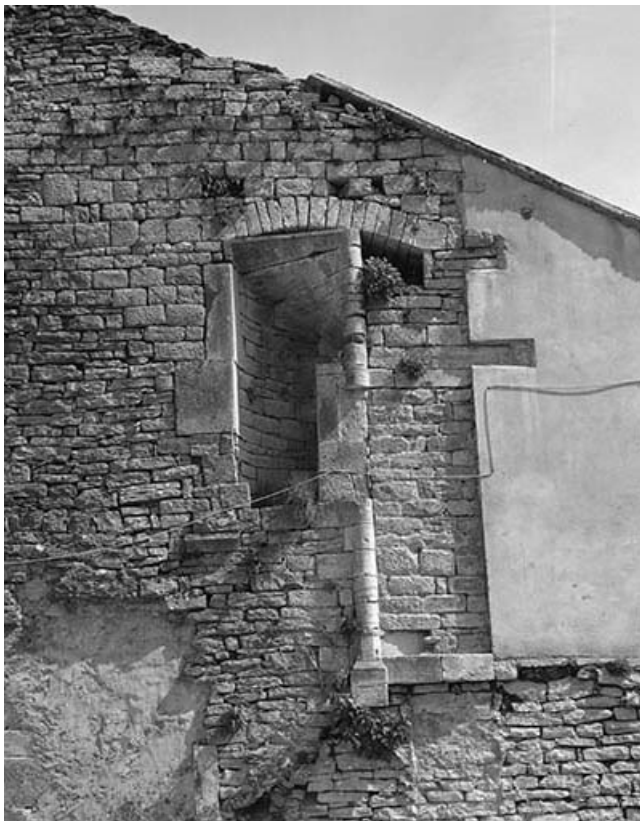
Vestige d'escalier : vue de face.
