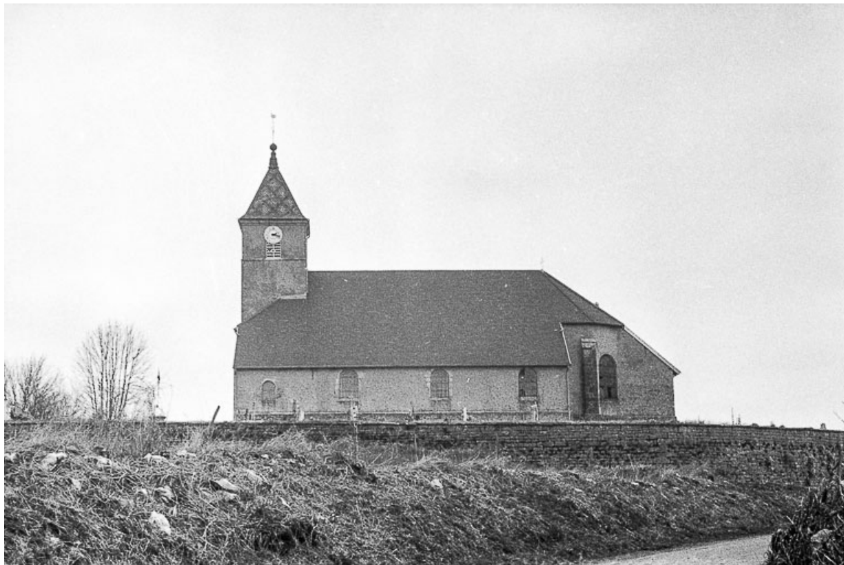
Façade latérale droite.
