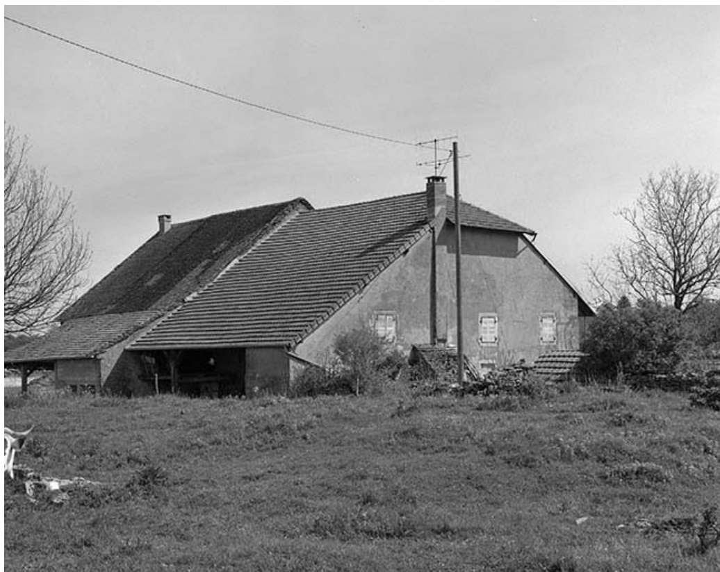
Façade postérieure et façade droite.
