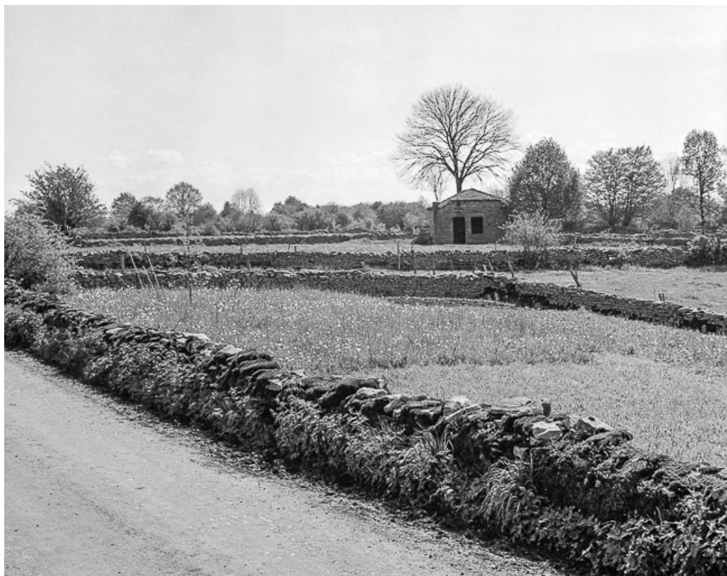
Mur en pierre sèche dit murger.
