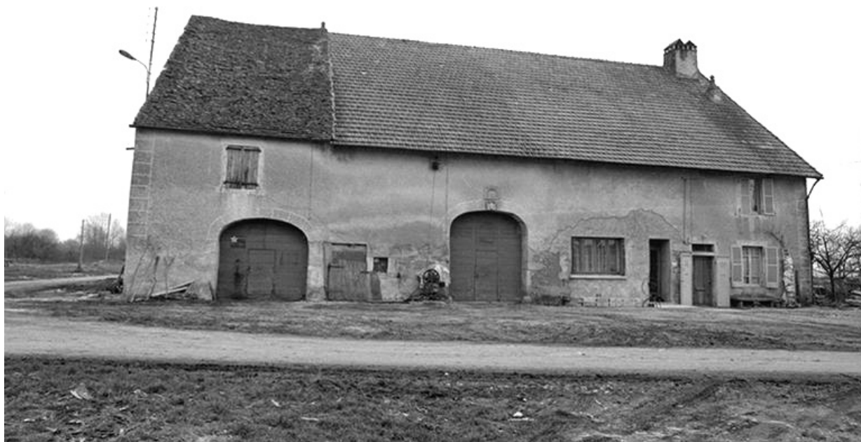
Ferme cadastrée 1940 B4 455 située le long du chemin vicinal ordinaire n° 4 : façade antérieure. 39, Le Fied
