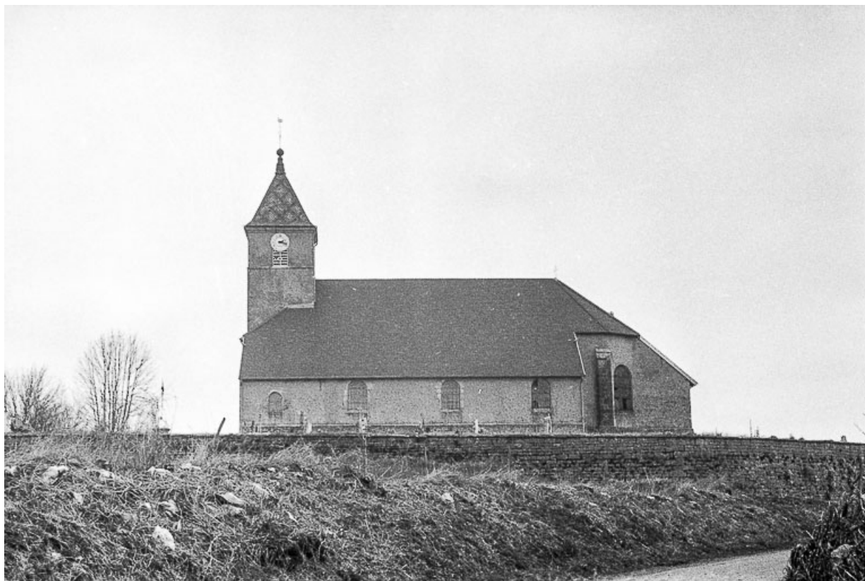
Façade latérale droite.
