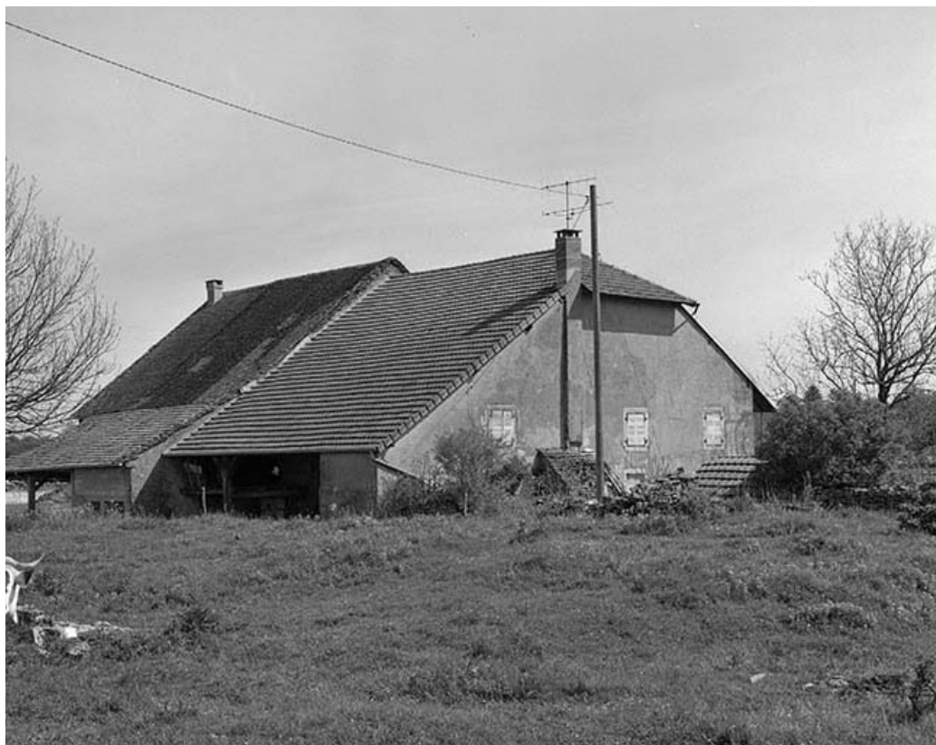
Façade postérieure et façade droite.
