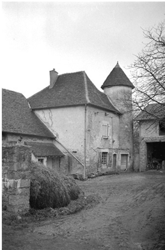
Ferme à tourelle : vue de la façade sur cour. 39, Domblans
