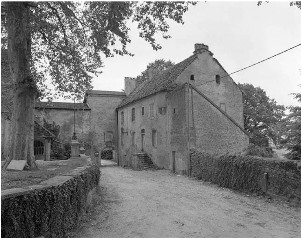
La maison canoniale. 39, Château-Chalon
