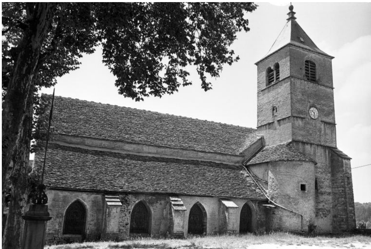
Façade latérale gauche. 39, Château-Chalon
