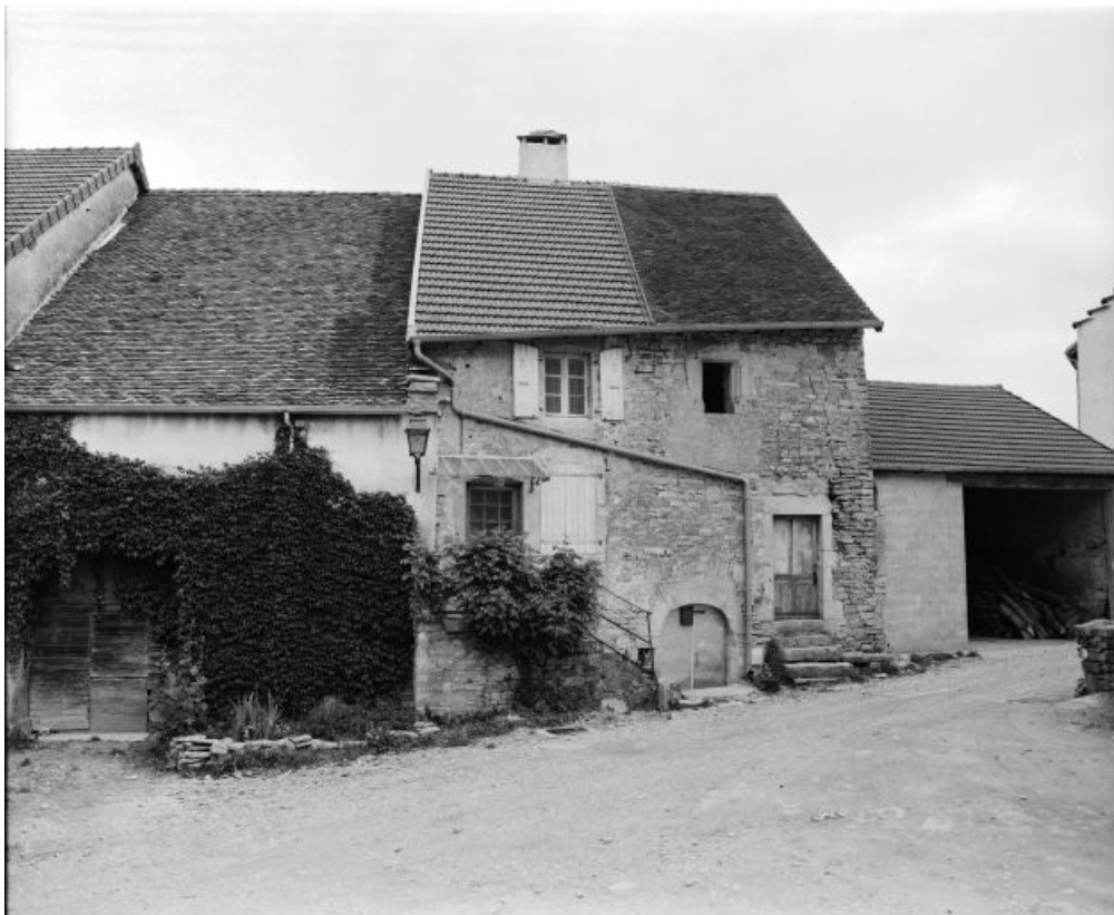
Façade antérieure. 39, Château-Chalon
