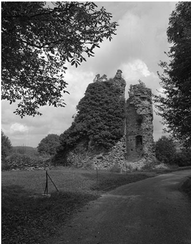
Le château-fort, vu depuis le sud. 39, Château-Chalon
