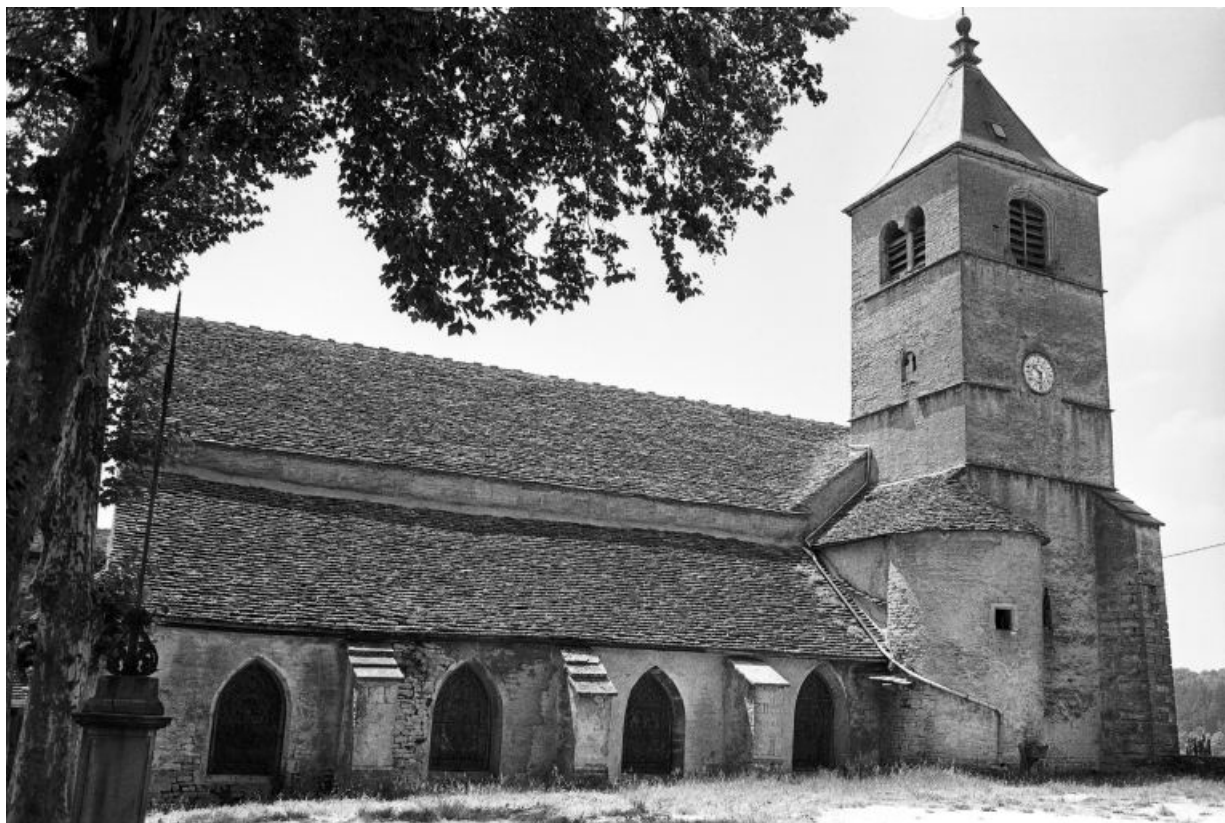
Façade latérale gauche. 39, Château-Chalon
