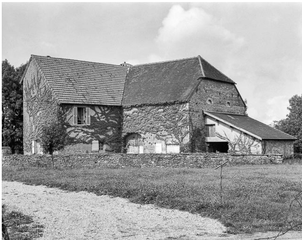
Vue rapprochée depuis le sud-est.
