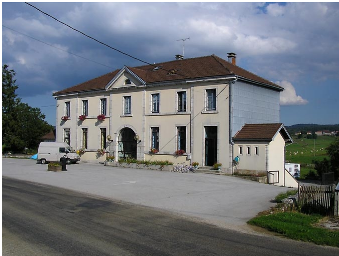
Façade antérieure vue de trois quarts.
