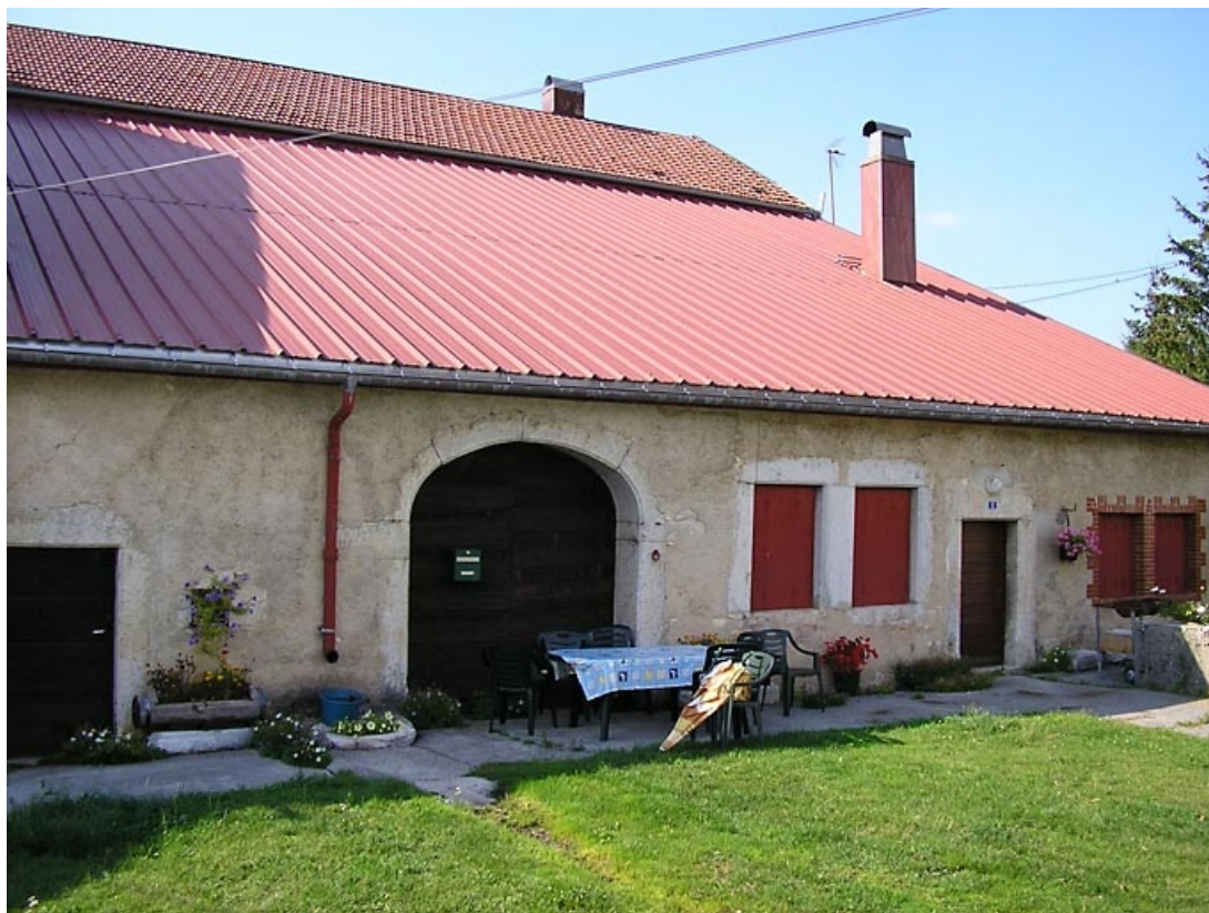
Vue de la façade antérieure.
