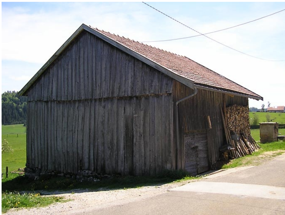
Pignon postérieur et façade latérale vus de trois quarts. 39, Prénovel
