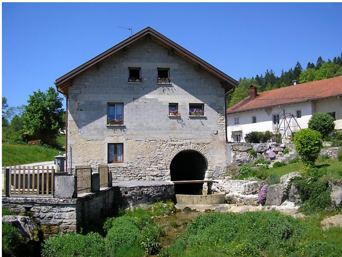
Vue générale du pignon nord et du canal. 39, Prénovel
