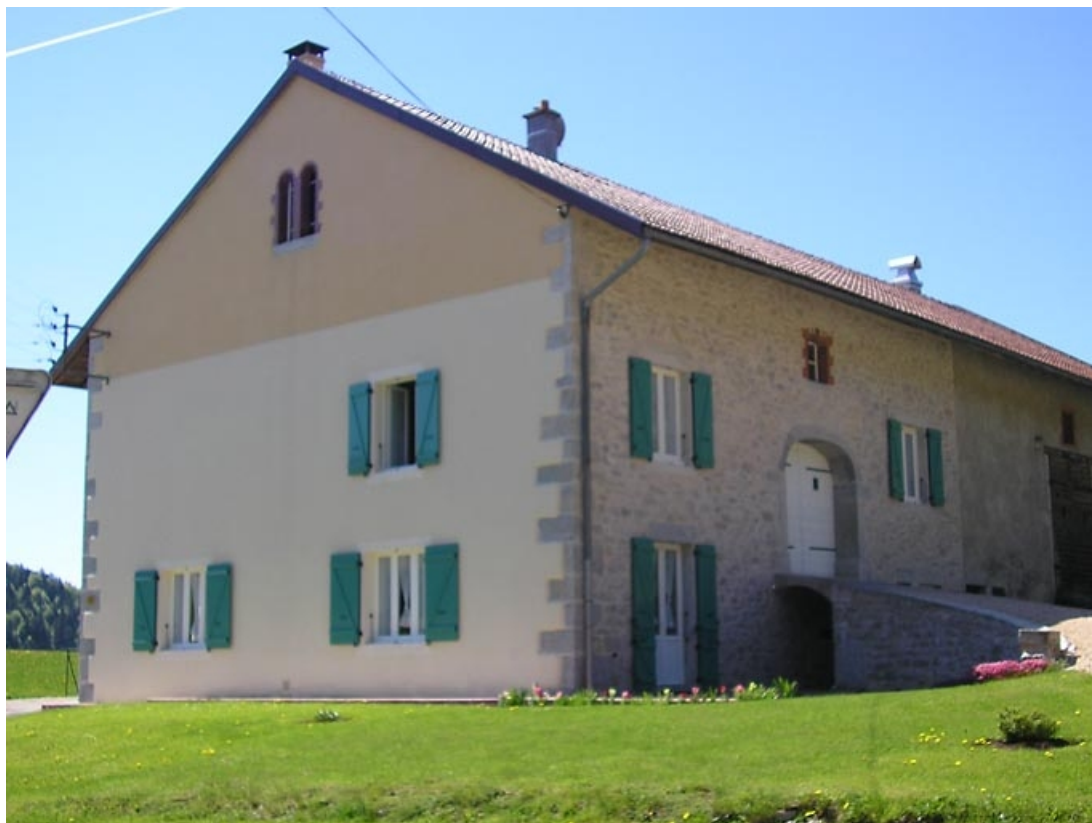
Pignon sud et façade postérieure vus de trois quarts.
