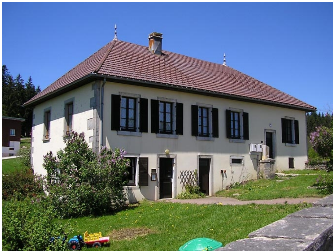
Vue de trois quarts sur façade antérieure.
