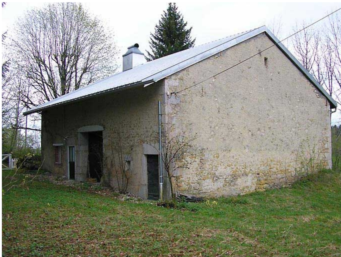
Pignon nord et façade postérieure vus de trois quarts.
