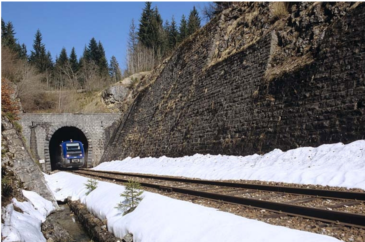
Vue d'ensemble de la tête côté La Cluse, avec autorail X 73500.
