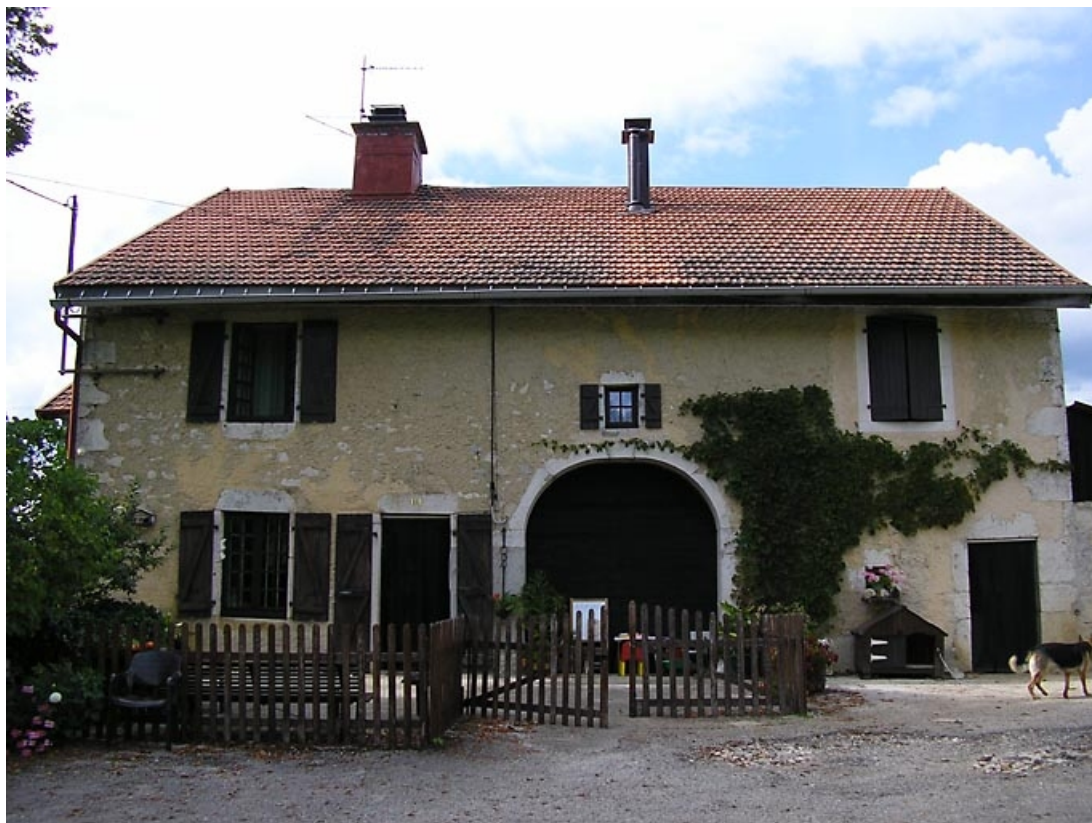
Vue générale de la façade antérieure.
